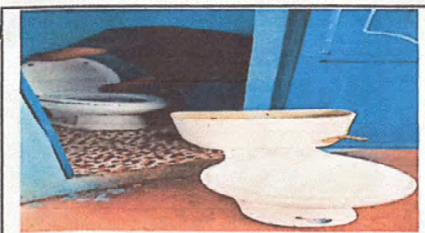
Foto 5: arreglo de baños
